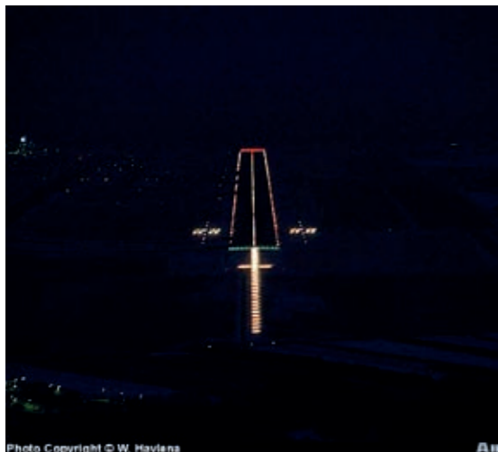
Klasszikus CAT I bevezető fénySOR (Bécs repülőtér /LOWWI, RWY 14)
