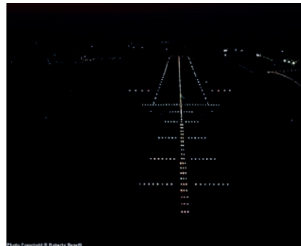
Távolságcódolt CAT I bevezető fénySOR (Málta, Luqa repülőtér /LMML, RWY 32 – 2004-ben)
